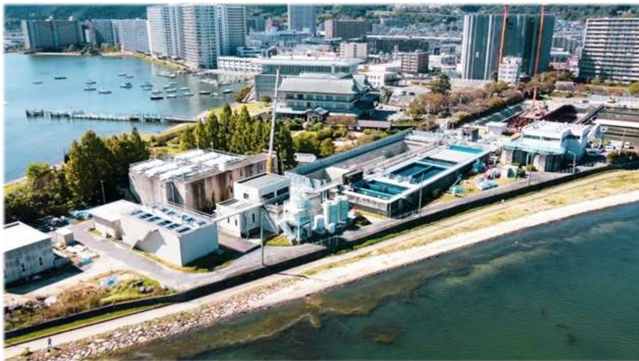
【更新改良中の柳が崎浄水場】
