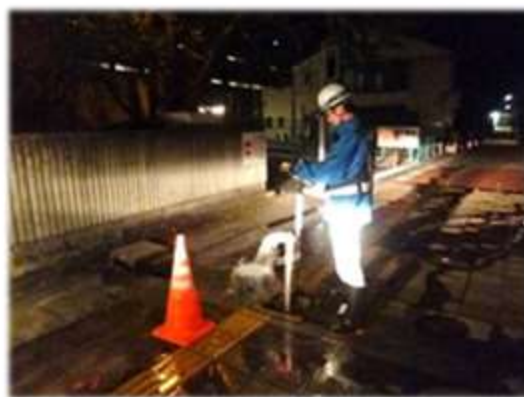
【水道管の洗浄作業（夜間作業）】
