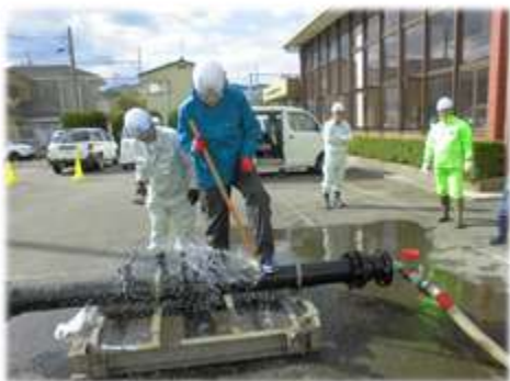
【漏水箇所修繕研修】
