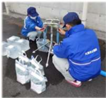
【仮設給水栓による応急給水活動】
