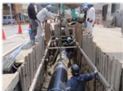
【基幹管路における耐震管の布設状況】 （ダクタイル鋳鉄管 NS 形 φ600mm）
