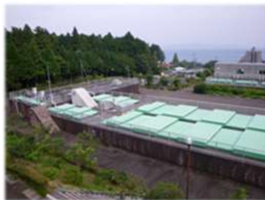
【浄水施設の覆蓋化（八屋戸浄水場）】
