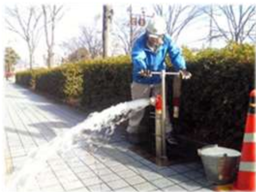
【水道管の洗浄作業（昼間作業）】
