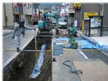
【配水支管における耐震管の布設状況】 （ダクタイル鋳鉄管 GX 形 φ200mm）
