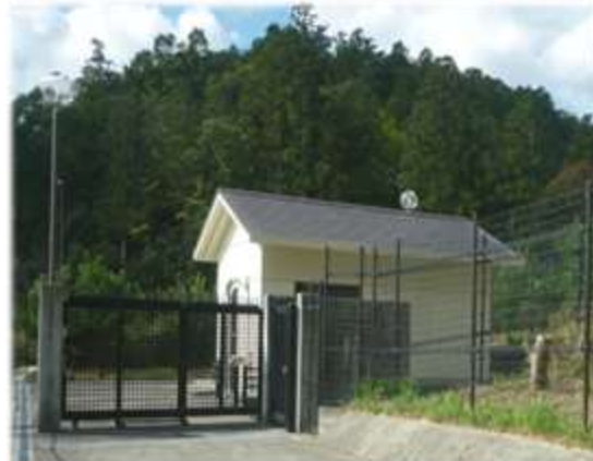
【南小松加压施設】
